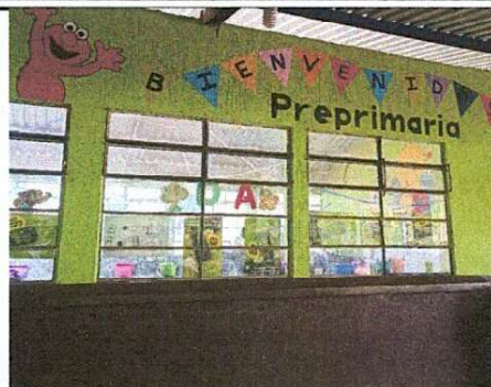
Foto 8: PINTURA DE MUROS INTERIORES
