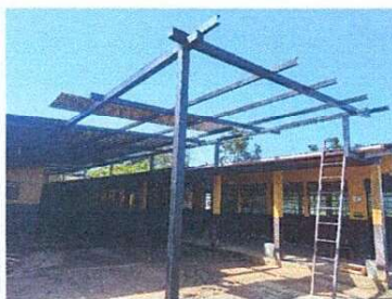
Foto 3: MANTENIMIENTO DE ESTRUCTURA DE METAL
