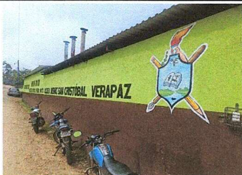
Foto7: PINTURA DE MUROS EXTERIORES
