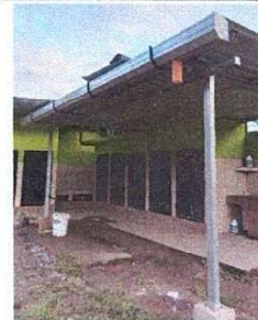
Foto 2: CAMBIO DE ESTRUCTURA DE METAL Y LAMINAS
