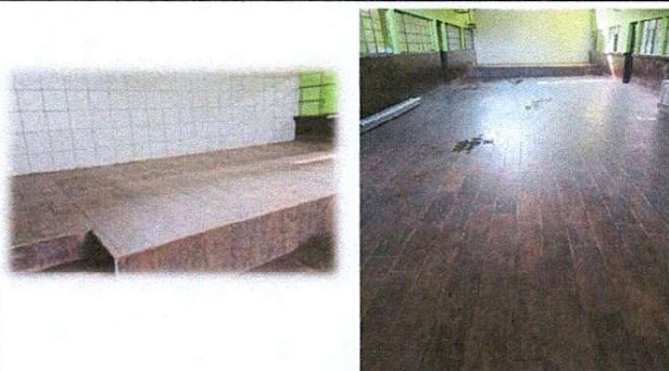
Foto 10: SUSTITUCIÓN DE PISO CERAMICO EN SALÓN
