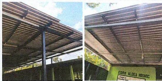
Foto1: CAMBIO DE LAMINAS
