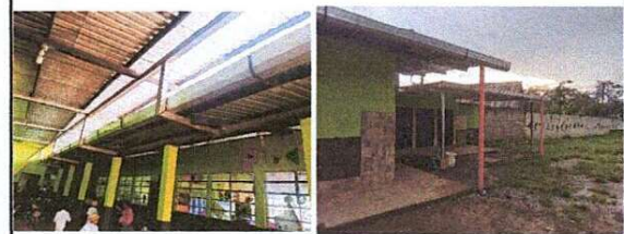
Foto 6: SUSTITUCIÓN DE CANAL PVC
