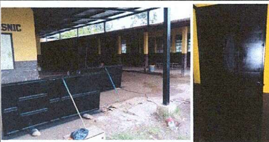
Foto 5: MANTENIMIENTO DE PUERTA DE AULAS
