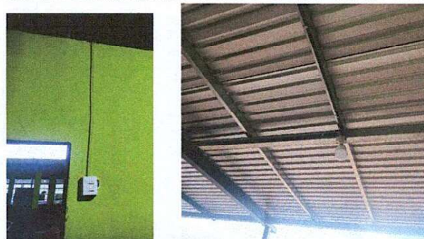
Foto 12: REPARACIÓN DE SISTEMA ELECTRICO
